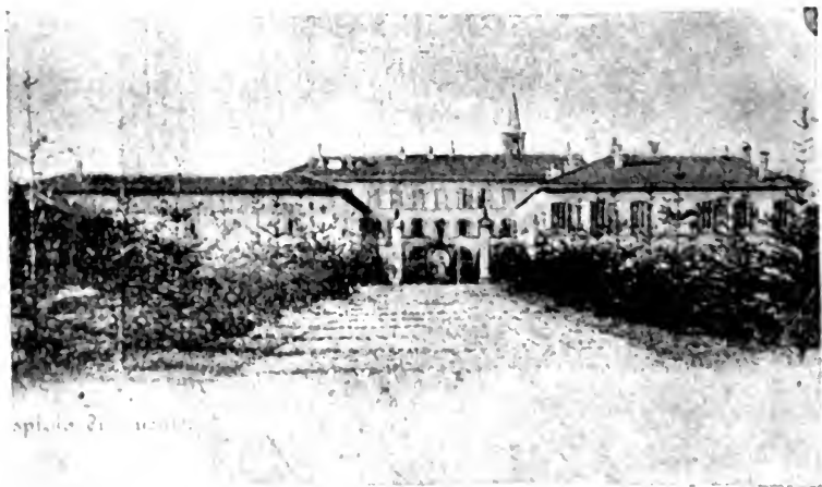
LA CASA DI TRIESTE - Facciata interna.
